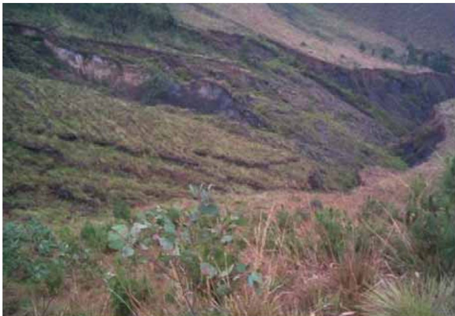
Eine der von Erosion betroffenen Stellen, die schon – im Vordergrund – mit Bäumen bepflanzt wurde, auch mit Eukalyptus, damit der Boden austrocknet und nicht weiter ins Rutschen kommt.
